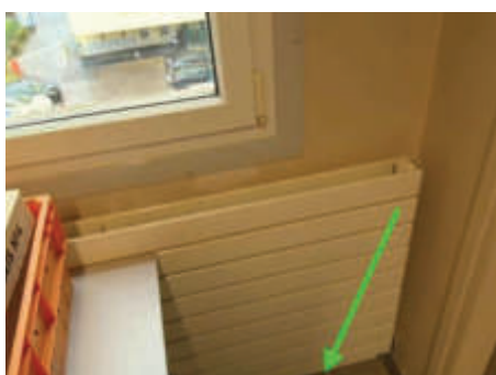
Matériaux : ZPSO-003 Prélèvement : P010 Description : Enduit à base de plâtre lissé ou taloché+Peinture Localisation : 3ème étage Aile C - Archive 327 Résultat : Absence d'amiante
