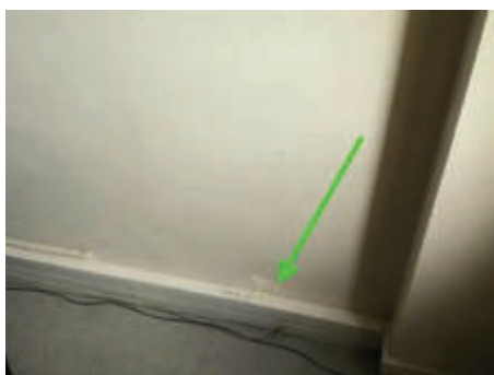
Matériaux : ZPSO-022 Prélèvement : P028 Description : Enduit à base de plâtre lissé ou taloché+Peinture Localisation : 3ème étage Aile C - Bureau 330 Résultat : Absence d'amiante
