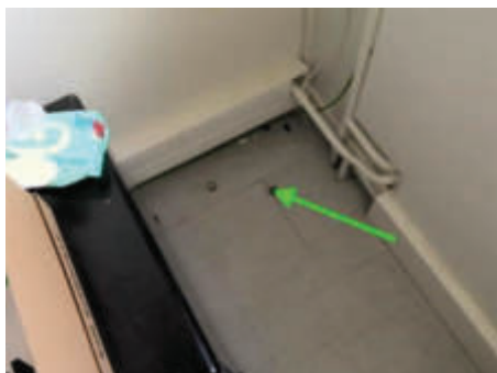
Matériaux : ZPSO-031 Prélèvement : P047 Description : Ragréage Localisation : 3ème étage Aile C - L.T Résultat : Absence d'amiante
