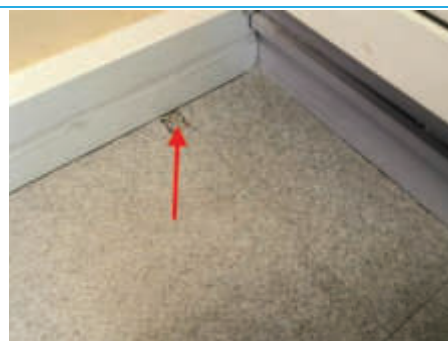
Matériaux : ZPSO-001 Prélèvement : P013 Description : Dalle de sol Beige+Colle noire Localisation : 3ème étage Aile C - Bureau 329; 3ème étage Aile C - Bureau 326; 3ème étage Aile C - Bureau 325; 3ème étage Aile C - Dgt 2 Résultat : Présence d'amiante
