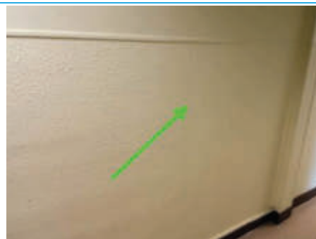
Matériaux : ZPSO-006 Prélèvement : P007 Description : Enduits à base de plâtre ou ciment projetés, lissés ou talochés+Peinture à goutte Localisation : 3ème étage Aile C - Couloir 1 Résultat : Absence d'amiante
