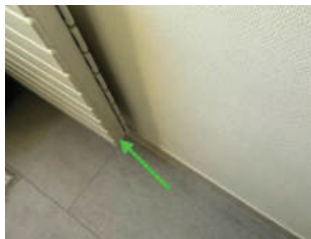
Matériaux : ZPSO-030 Prélèvement : P046 Description : Colle de carrelage+Chappe Localisation : 3ème étage Aile C - L.T Résultat : Absence d'amiante
