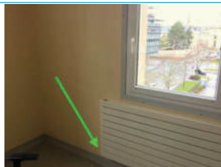
Matériaux : ZPSO-012 Prélèvement : P018 Description : Enduit à base de plâtre lissé ou taloché+toile de verre peinte Localisation : 3ème étage Aile C - Bureau 326 Résultat : Absence d'amiante
